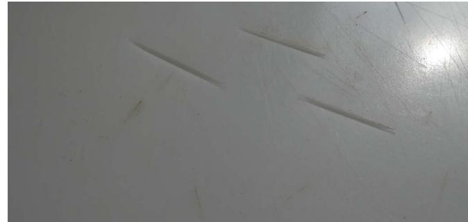
Einzelne Vertiefungen (z.B. Einschnitte mit Säge) können mit neuer Technik wieder „verspachtelt“ werden.
